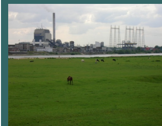
Waal Crossing - elektrárna PGM, Waal a pastviny
